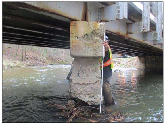
Bent 1 Pier: 30" WIDE X 33" HIGH X 7" DEEP SPALL IN UPSTREAM FACE OF PIER AT WATER SURFACE
