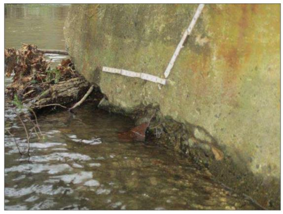
Bent 1 Pier: 48" LONG X 16" HIGH X 7" DEEP SPALL IN SPAN 1 FACE OF PIER AT WATER SURFACE AT UPSTREAM END
