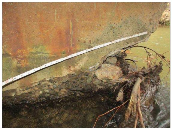
Bent 1 Pier: SPAN 2 FACE AT WATER SURFACE EXTENDING FROM UPSTREAM END, 15' LONG X 12" HIGH X 3" DEEP SPALL
