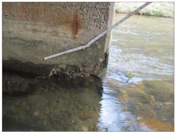
Bent 1 Pier: 20" LONG X 12" HIGH X 3" DEEP SPALL IN SPAN 1 FACE OF PIER AT WATER SURFACE AT DOWNSTREAM END
